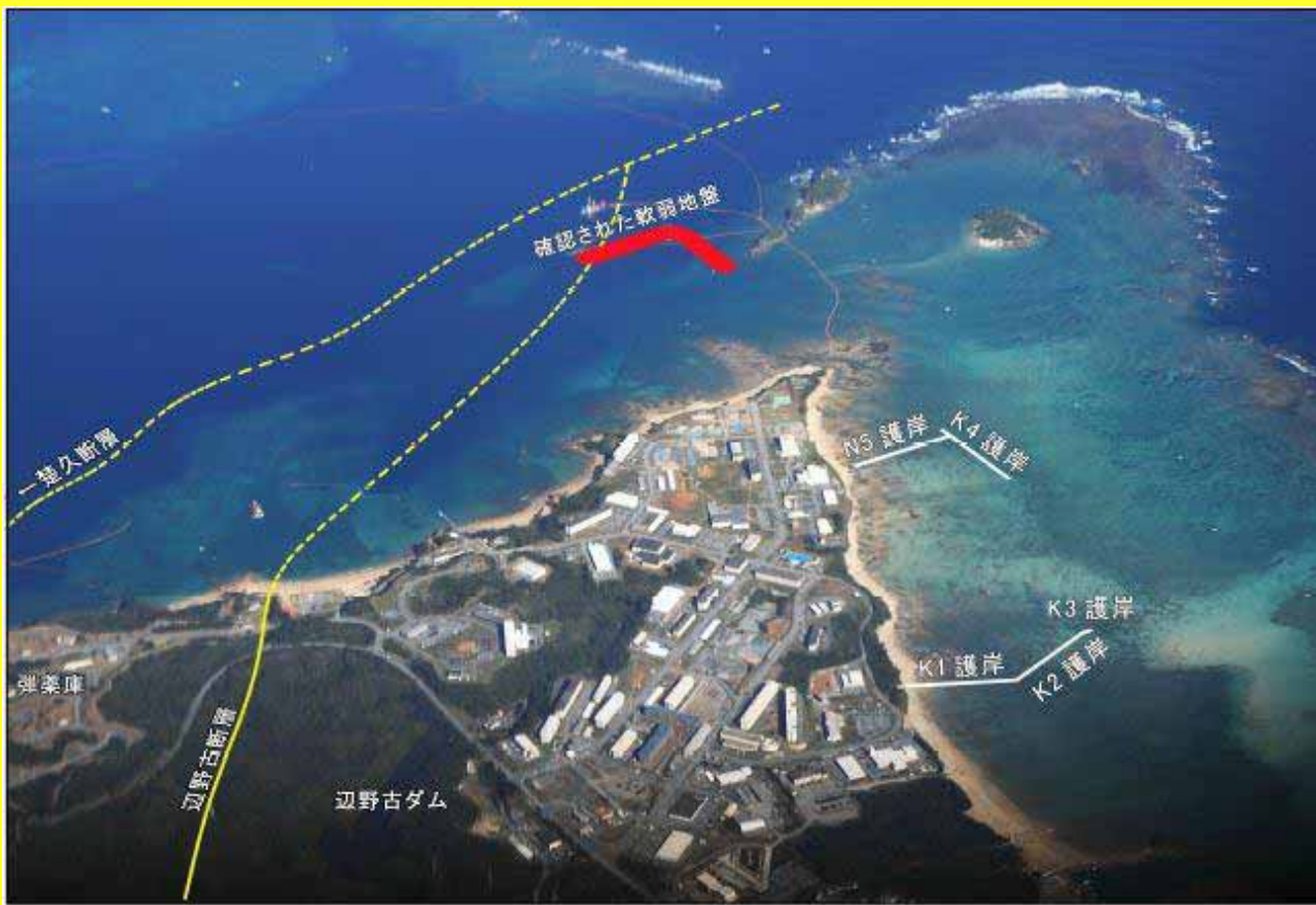
埋め立て予定地の海底は軟弱地盤で、活断層の存在も明らかになりました。 (辺野古崎右側の実線で護岸工事が進められています)
